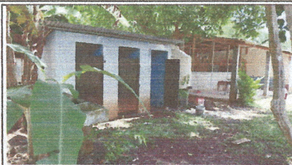
FOTOGRAFIA 2: Vista del modulo de baños a reparar y del area de tinaco.
